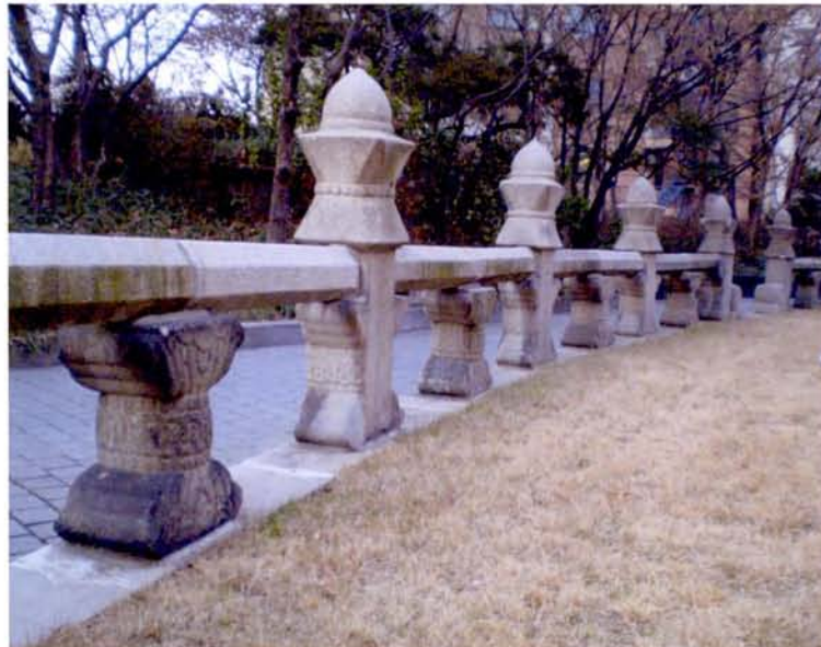
석재 난간 (보수 후)
