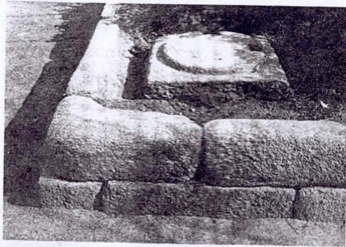
↑ 基壇 甲石과 礎石 기단 바닥에 敷塼되었던 물림홈이 甲石上部 안쪽에 보인다
